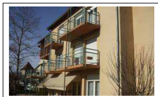
Etablissement d'Hébergement pour Personnes Agées Dépendantes (EHPAD) du Pré d'Aubié
